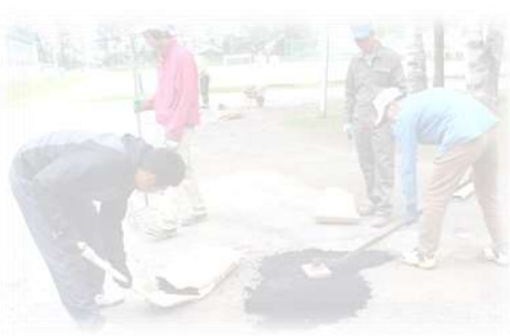
ロータリーアスファルト補修作業
