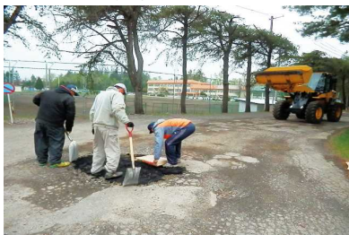
ロータリー補修作業
