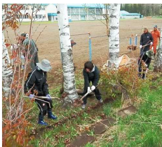
側溝清掃 & うんてい塗り作業
