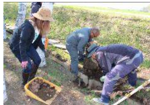
側溝清掃作業
