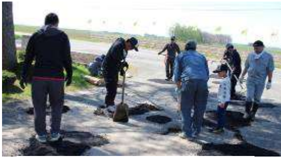
ロータリーアスファルト補修作業
